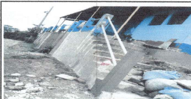
Foto 4: Pintura en muros exteriores e interiores.
