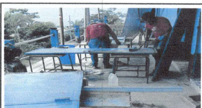
Foto 6: Mantenimiento a estructura (lijado, cepillado, sujeciones, aplicación de pintura).
