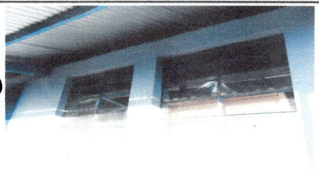
Foto 3: Sustitución de vidrios
