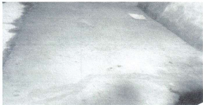
Foto 1: Sustitución de piso de torta de concreto.
