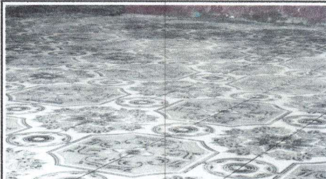
Foto 2: Sustitución de piso cerámico
