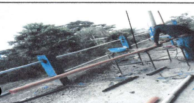
Foto 5: Sustitución de barandas de metal de pasamanos.
